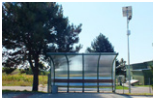
Opravená aut. zastávka solární světlo
