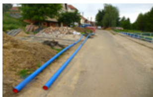
Budování vodovodu sklepy u hřiště
