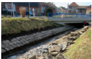
Oprava a čištění koryta potoka u hasičky
