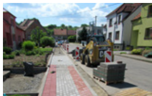
Budování chodníků v obci
