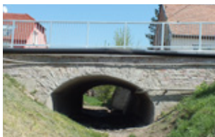
Rekonstrukce mostu přes Hovoranský potok
