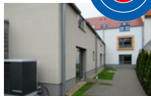
Dům seniorů s tepelným čerpadlem
